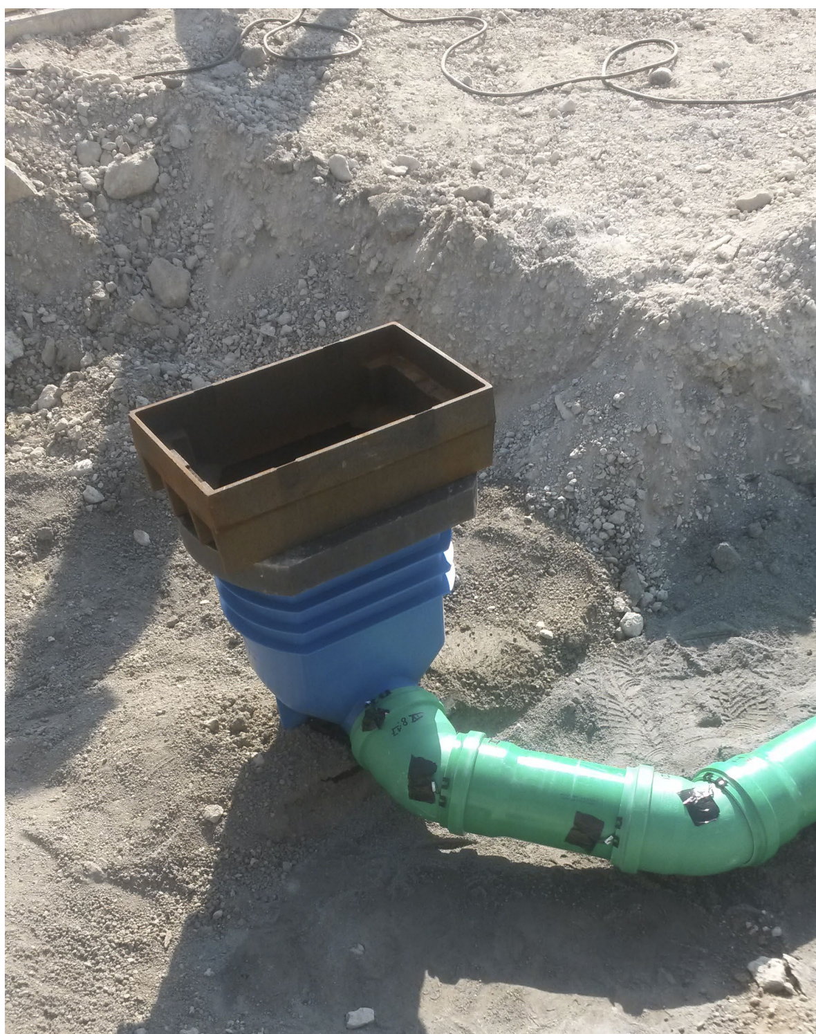
Verschweißter Straßenablauf in Verbindung mit KG 2000
