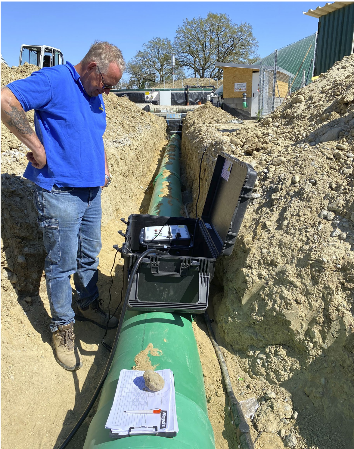
Verschweißung von KG 2000 SN 16 Rohren DN 500 als Transportleitung im AwSV-Bereich
